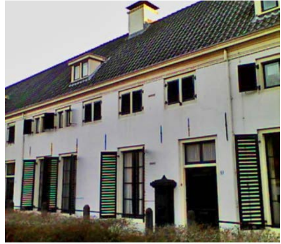
Wanneer vocht achter geschilderd pleisterwerk niet kan uitdampen, zoals hier vooral bij de regenpijp rechts en bij de muurdammen beneden, dan is ook dat goed thermografisch te detecteren. Met een specifiek palet 'valse kleuren' is dat heel goed in beeld te brengen. © ejn
